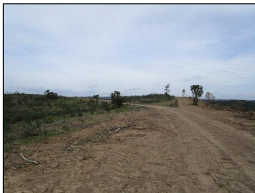
Figura 93 - Vista geral do terreno na área de implantação do Aerogerador 2
