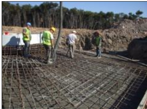
Figura 9 - Imagem exemplificativa de cofragem e betonagem da sapata de aerogerador. Fonte: STRIX
