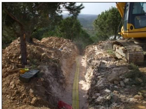
Figura 11 - Imagem exemplificativa de realização de vala de cabos. Fonte: STRIX
