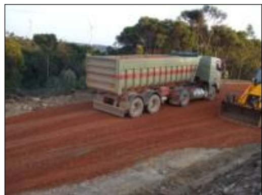
Figura 8 - Imagens exemplificativas de abertura de acessos e aplicação de tout-venant . Fonte: STRIX
