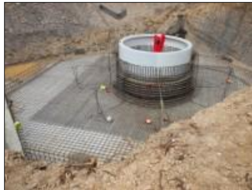
Figura 9 - Imagem exemplificativa de cofragem e betonagem da sapata de aerogerador. Fonte: STRIX
