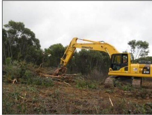
Figura 7 - Imagem exemplificativa de desmatamento para obras de construção de sapata de aerogerador. Fonte: STRIX
