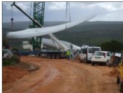
Figura 10 - Imagem exemplificativa de montagem de torre e pá de aerogerador. Fonte: STRIX
