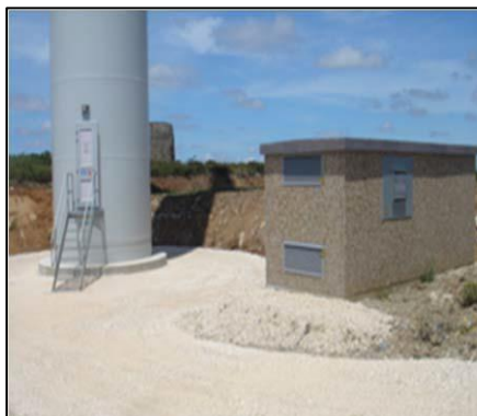
Figura 4 – Imagem ilustrativa de posto de transformação proposto e respectiva disposição espacial. Fonte: Proponente
