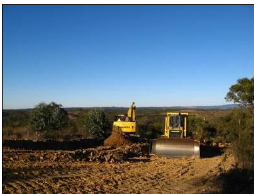
Figura 8 - Imagens exemplificativas de abertura de acessos e aplicação de tout-venant . Fonte: STRIX
